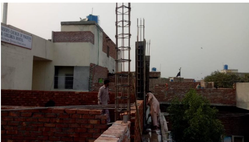
Afbeelding 3.1.1: Bouw nieuw gebouw voor project: 'The Saviours Welfare'.
