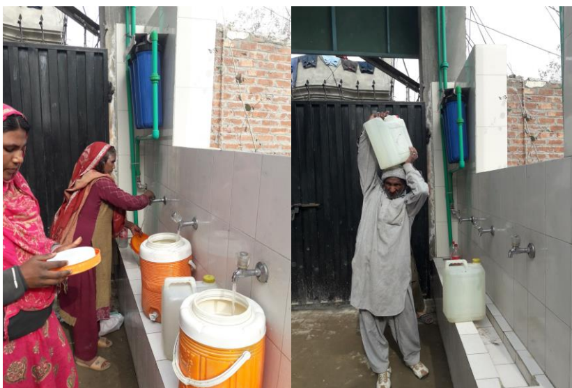
Afbeelding 3.1: Waterpomp in Khaliq Nagar
